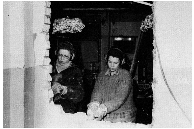
Durchbruch: In der Instandsetzung von Altbauten konnten die Bewohner*innen vielfach selbst Hand anlegen. (Bild: Anke Feja in: „Stattbau – anders planen, bauen, wohnen“. Hrsg. STATTBAU HAMBURG)
